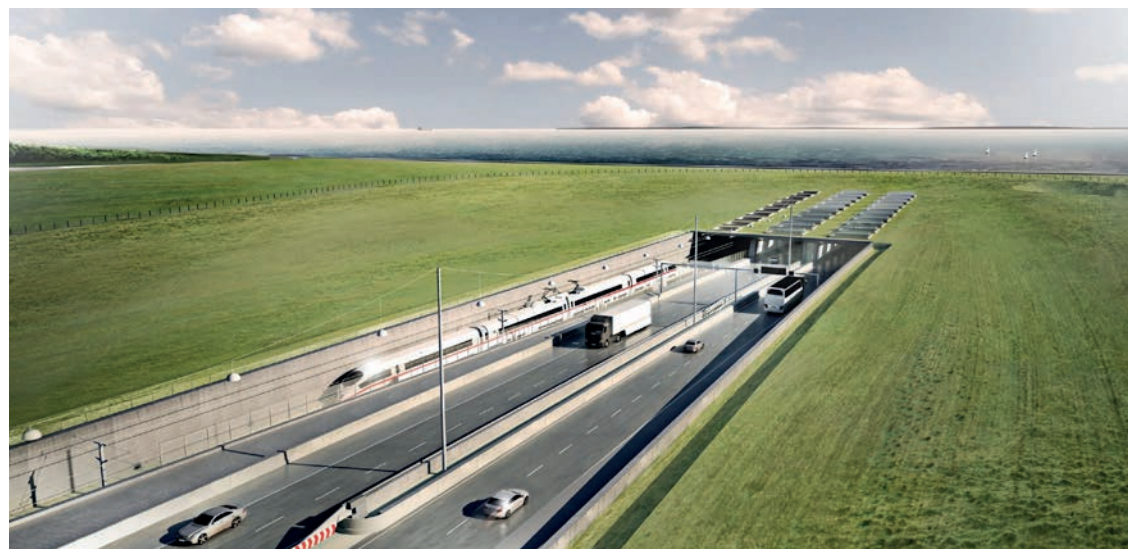
Fehmarnbelt tunnel. Foto: www.processminded.nl
